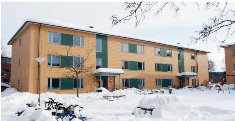
Figur 3 Brogården efter renovering (foto SP)
