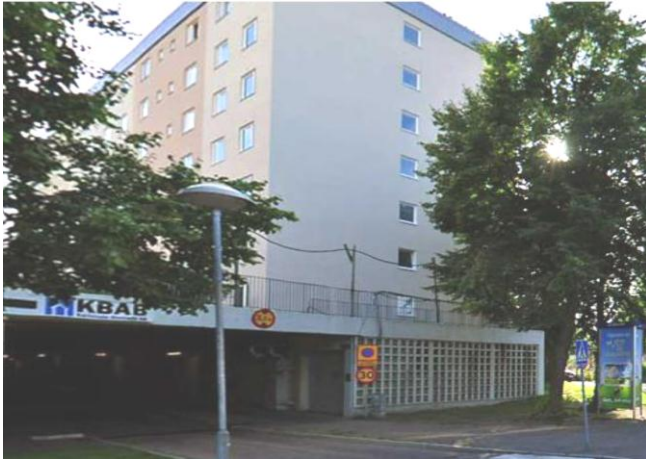
Figur 6 Orrholmen efter renovering
