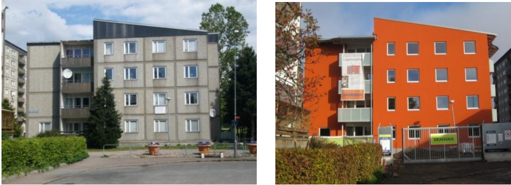
Figur 2 Backaröd före och efter renovering (foto SP)
